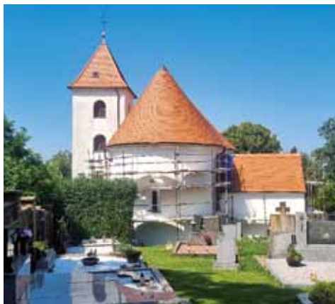
Další část opravy kostela je dokončena
